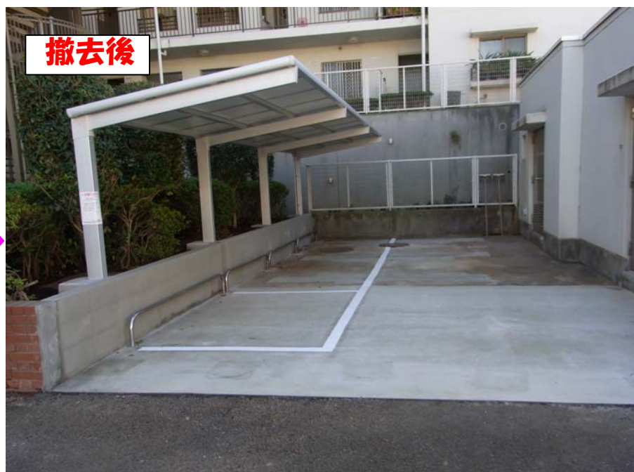
完成（受水槽撤去後駐輪場設置）
