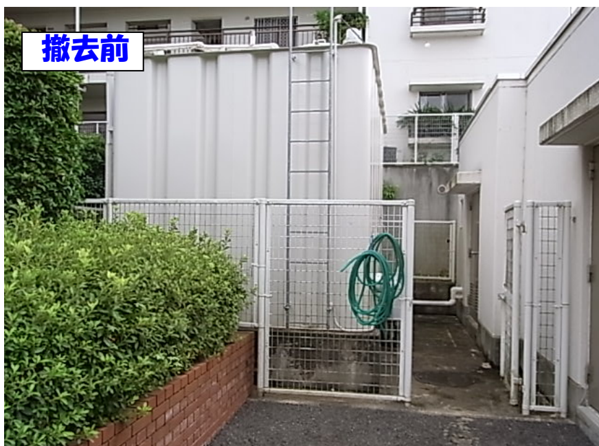
直結給水工事（鋼板製30ton受水槽）
