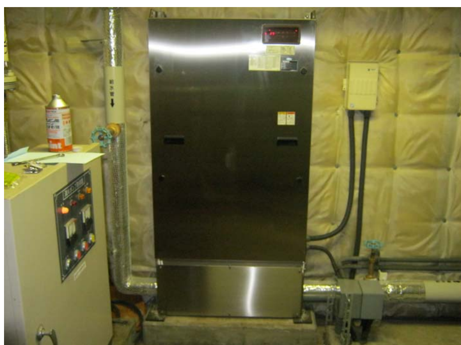
完成 直結増圧給水ユニット設置完了
